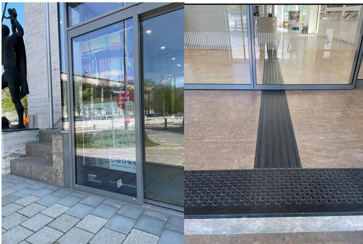
**Abbildung 3: Eingangstüren mit Spiegelung / Bodenleitsystem**
